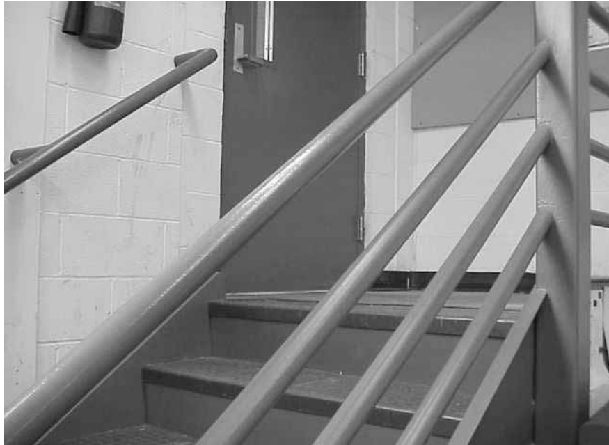
Space Beneath Machine Shop Hallway Door
