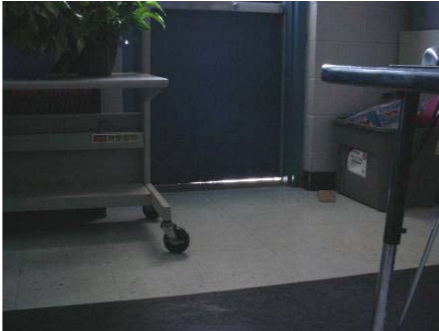
Space underneath Exterior Door
